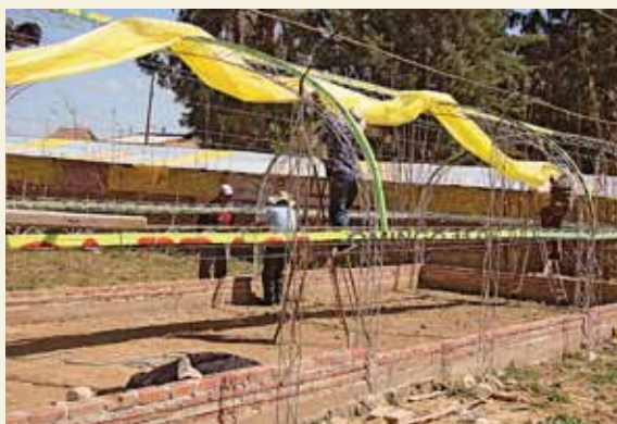
Fig. 8. Colocación de plástico a un invernadero en forma de curva.
