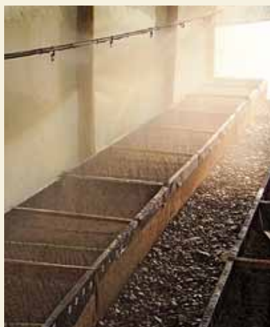
◀ Fig. 12. Tuberías de polietileno con nebulizadores en funcionamiento.
