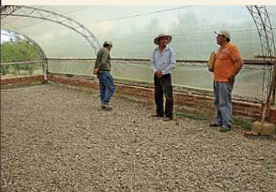
◀ Fig. 14. Piso cubierto con grava sobre plástico.
