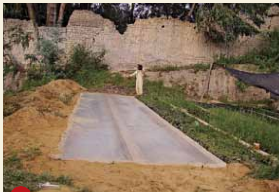
Fig. 27. a) Mojado del sustrato y removido; b) Colocado y tesado de la primera capa superior; c) Colocado y tesado de la segunda capa.
